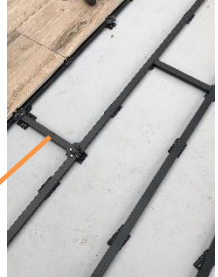
Queraussteifung mit M-Fix SMART Wichtig: max. Abstand 150 mm
